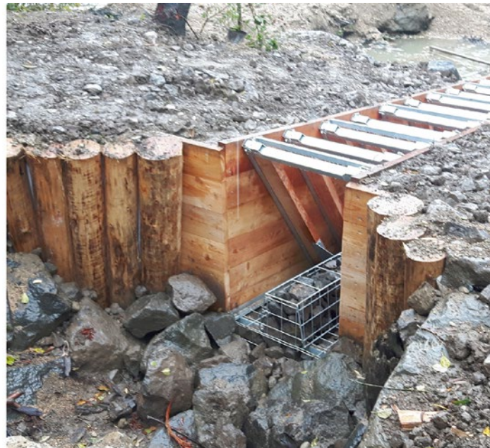
Bild 1: Schemaskizze (links) und Einbau des modifizierten Denil-Passes (rechts)
