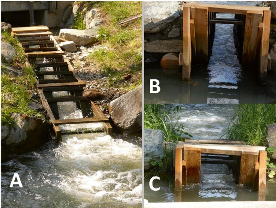
**Bild 1:** A) Modifizierter Denil-Pass, B) Einlaufbereich bei niedrigem Oberwasserstand, C) Einlaufbereich bei hohem Oberwasserstand
